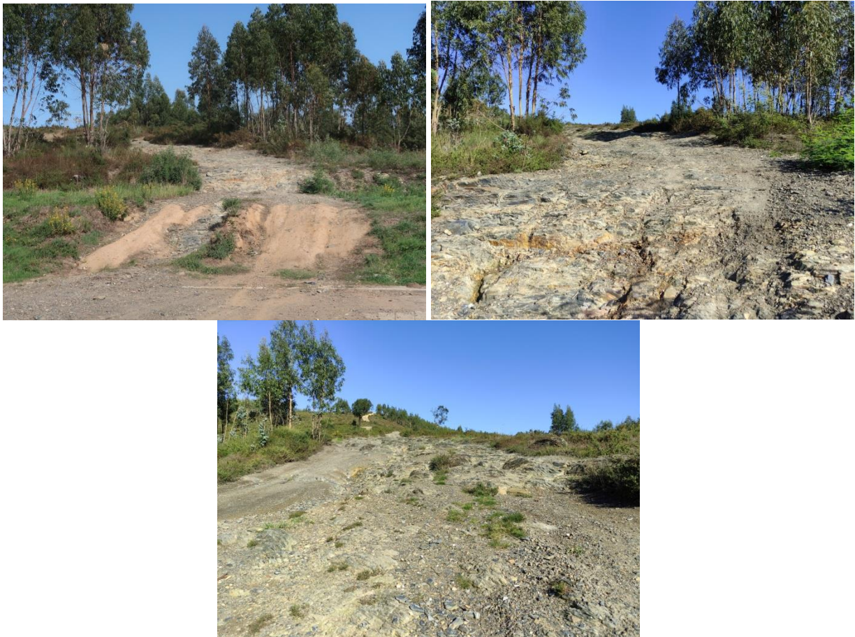
Figura 8.2 - Aspeto da rede de acessos sobre a encosta.
