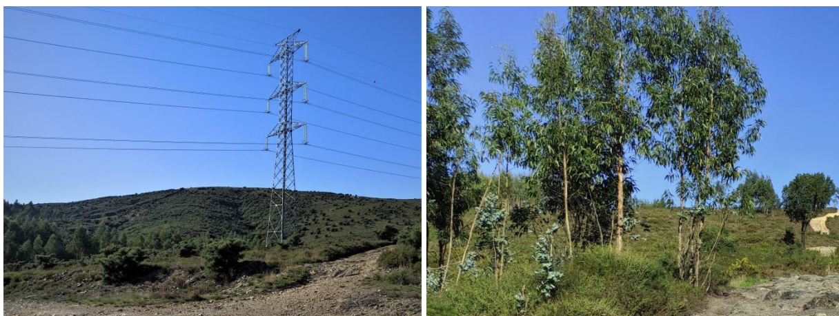
Fotografia 6.30 – Aspetos do corredor de estudo do troço da Linha Elétrica aérea.
