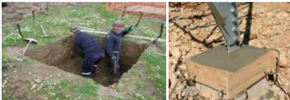
Figura 4.9 – Tipo de fundações para os apoios.
