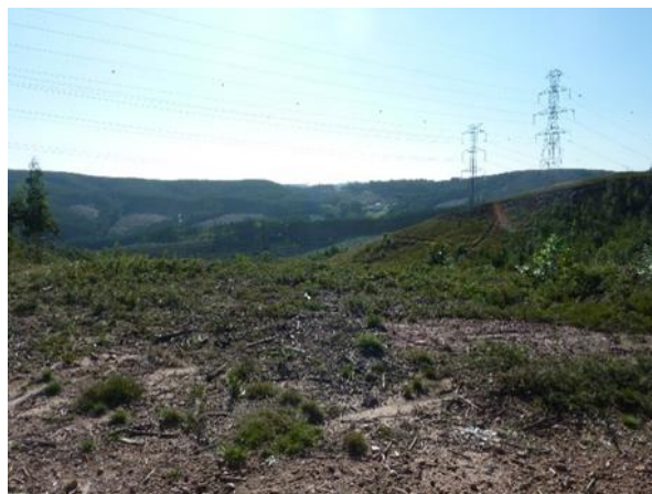
Fotografia 6.2 – Vista geral para noroeste da área da Central Fotovoltaica.
