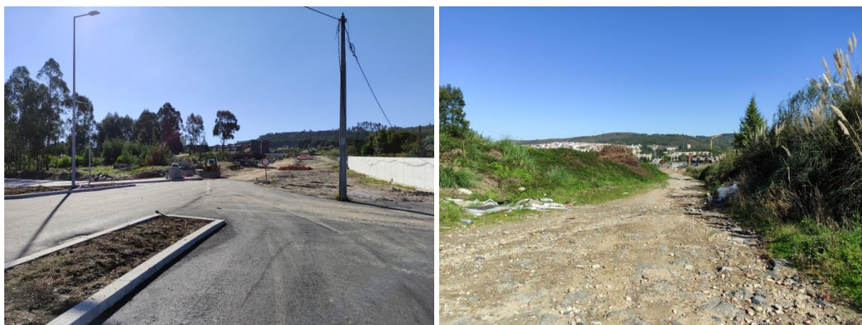
Fotografia 6.32 – Traçado subterrâneo na extensão da Avenida dos Descobrimentos em construção.
